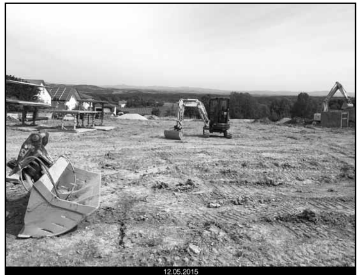
Erschließung des Baugebietes „Jägerwirth-Elenderhofwiese II“.
