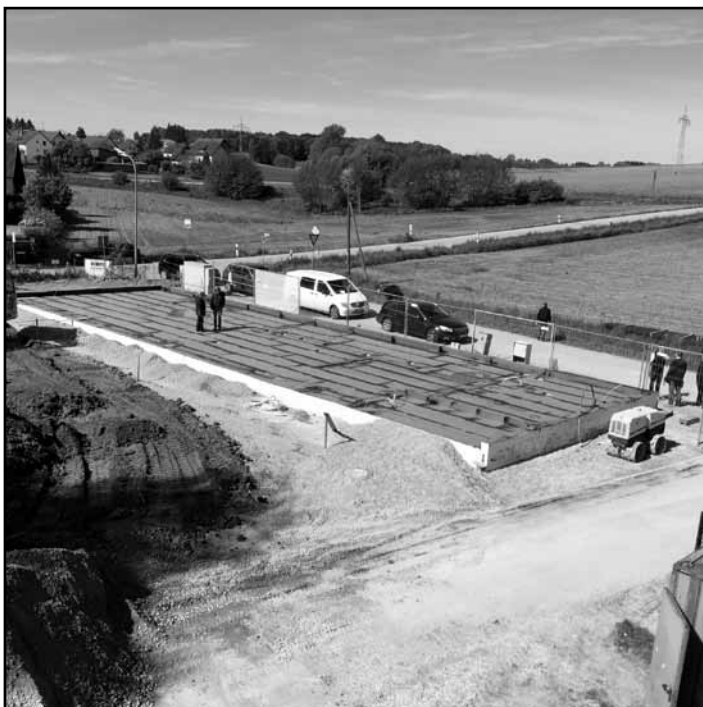
Neubau des eingruppierten Kindergartens Engertsham.
